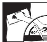
1. Estender a argamassa sobre a base, com o lado liso da desempenadeira e em seguida passar o lado denteado em ângulo de 60° para formar os cordões de assentamento. Devolver a argamassa aderida na desempenadeira ao recipiente, misturar sem adicionar água e utilizar novamente.
