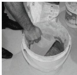
Foto 10: Preparo da argamassa colante – adição da água
