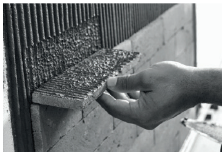
Foto 20: Assentamento correto. Cordões totalmente esmagados
