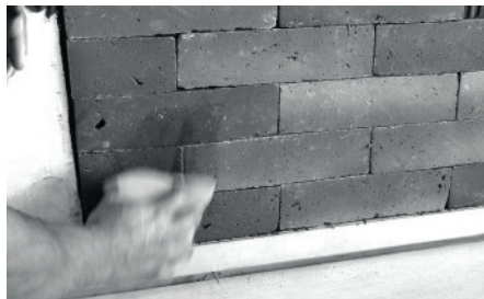
Foto 19: Limpeza do excesso de argamassa da lateral / superfície da placa
