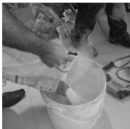
Foto 11: Preparo da argamassa colante – adição do pó
