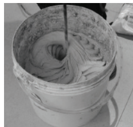
Foto 12: Mistura com haste helicoidal, formando uma pasta homogênea
