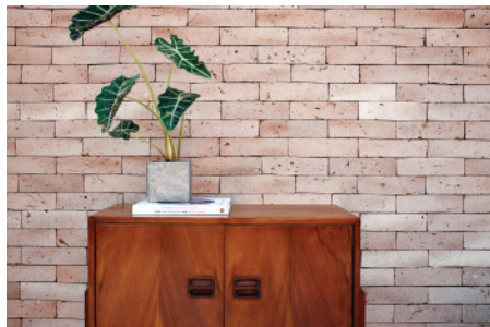
Foto 01: Assentamento com amarração de 50%
