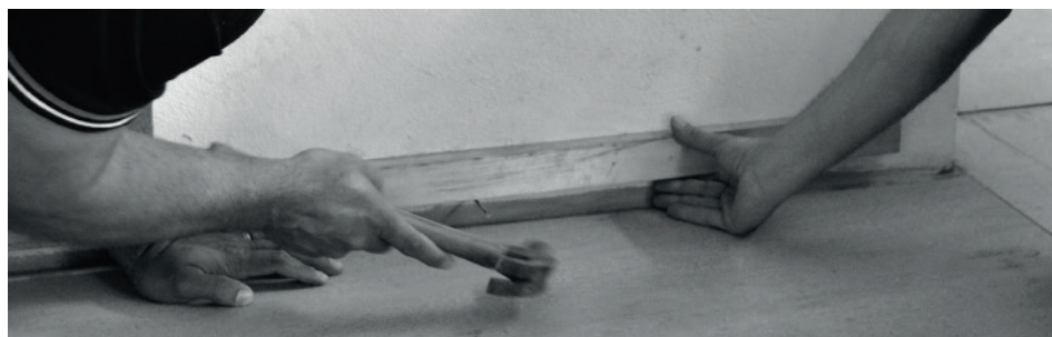
Foto 13: Fixação da régua metálica
