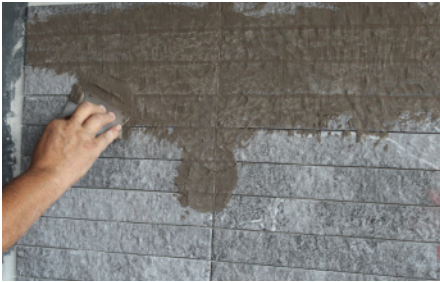
Foto 33: Aplicação do rejunte com desempenadeira de borracha
