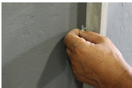
Foto 12: Conferência do nivelamento | irregularidades da parede
