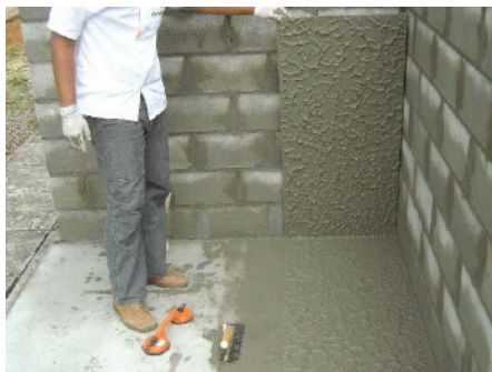
Foto 26: Tardoz da placa completamente preenchido por argamassa colante - CORRETO
