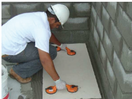
Foto 19: Posicione a peça cerca de 5cm do local exato do assentamento e empurre-a para a localização exata
