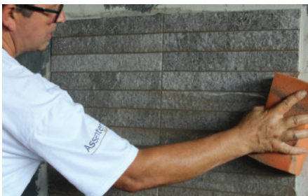
Foto 35: Limpeza do rejunte com esponja umida
