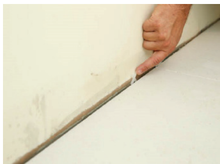
Foto 24: Colocação do espaçador de 5mm para garantir o espaçamento correto da junta.
