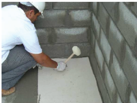
Foto 20: Percussão da peça com martelo de borracha
