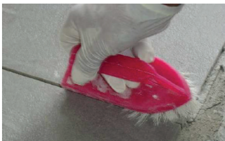
Foto 25: Remoção do excesso de argamassa colante com escova de cerdas de Nylon
