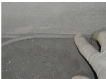
Foto 23: Inserção do tarugo de polietileno na junta de dessolidarização.
