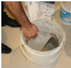
Foto 14: Preparo da argamassa colante – adição da água
