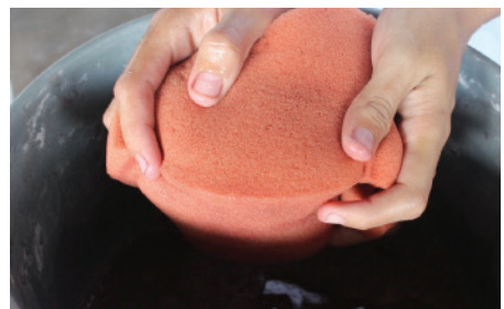
Foto 36: Lavação da esponja para limpeza do rejunte
