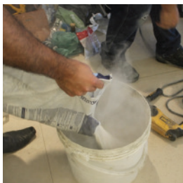
Foto 15: Preparo da argamassa colante – adição do pó
