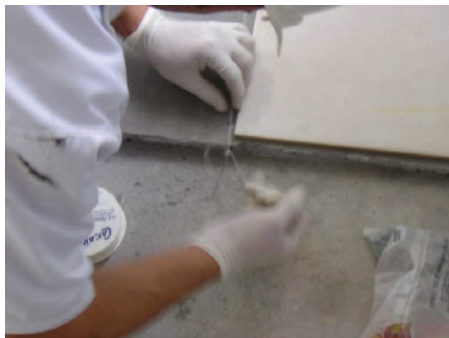
Foto 17: Linha de Nylon alinhada com a peça
