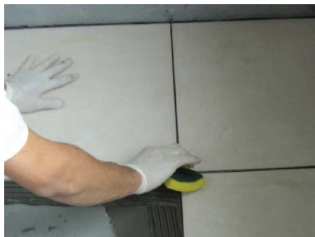
Foto 22: Limpeza do excesso de argamassa colante com esponja úmida
