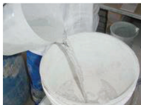
Foto 30: Medida e adição de água para realizar a mistura da argamassa de rejuntamento
